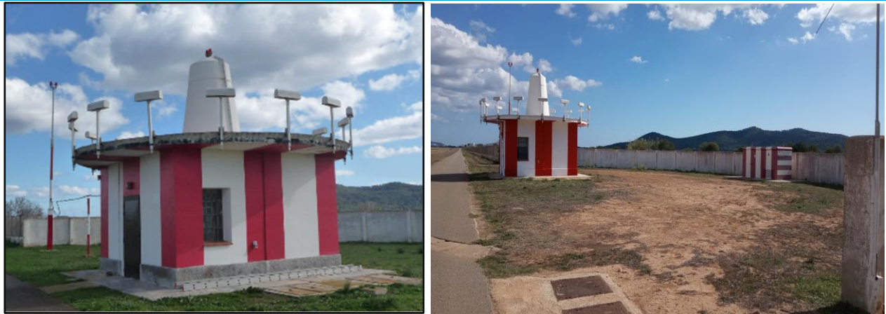
Figura 3 – Sistema CVOR/DME con antena DME abatible y Centro de Transformación asociado existentes. Fuente: Proyecto de ENAIRe
