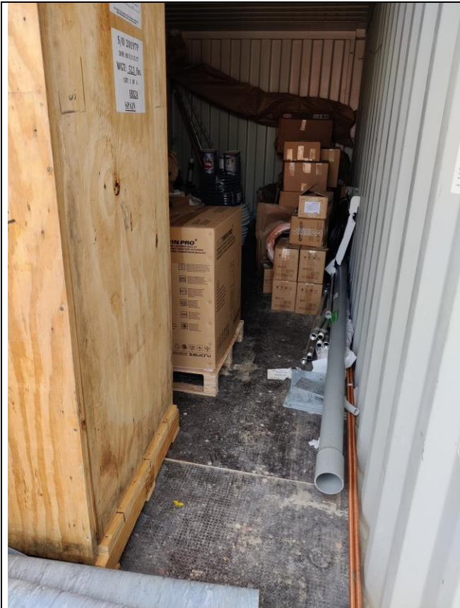
Interior del contenedor de acopios: equipos a instalar en el VOR
