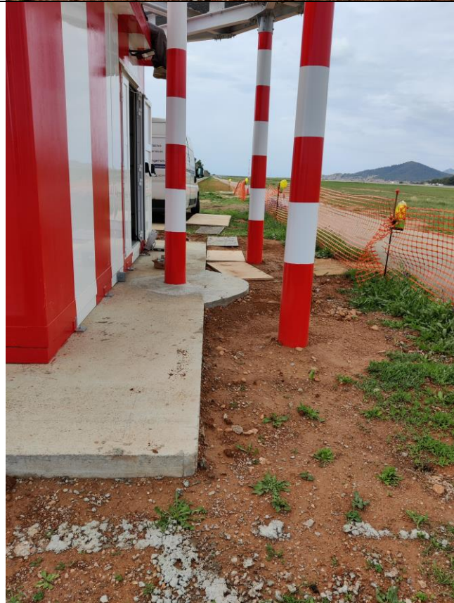
Cimentaciones y pilares
