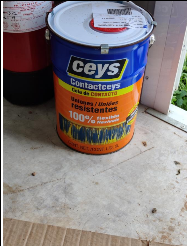
Interior de la caseta de obra: envase de pegamento
