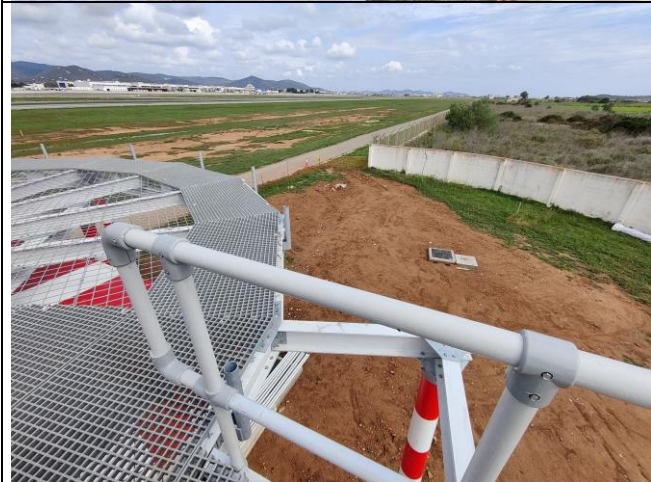
Muro de separación, arqueta y base del pararrayos
