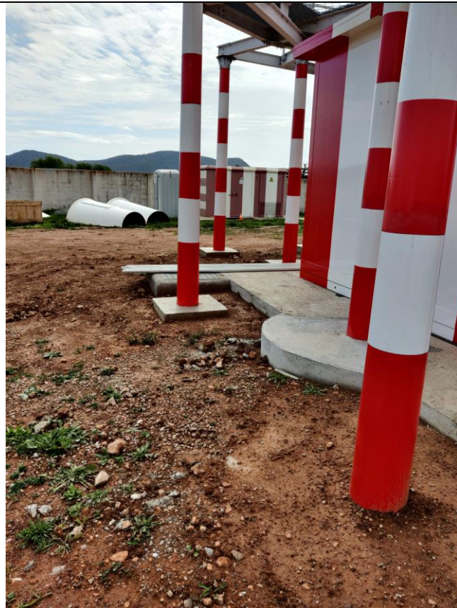
Cimentaciones y pilares
