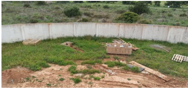
Caseta de obra, restos, contenedor y aspecto general de la zona de obra
