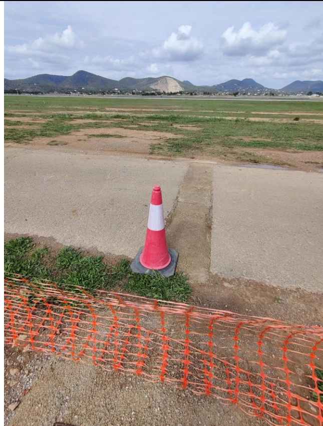
Señalización de obra en la vía de acceso
